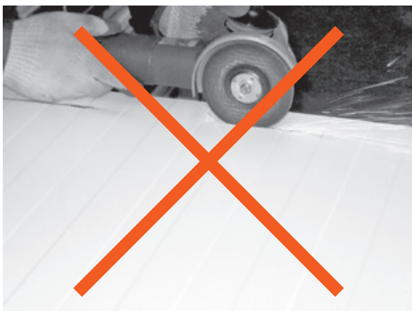
Obr. 8 a 9. Neřežte panely úhlovou bruskou, protože může dojít k poškození antikorozičního povlaku.
