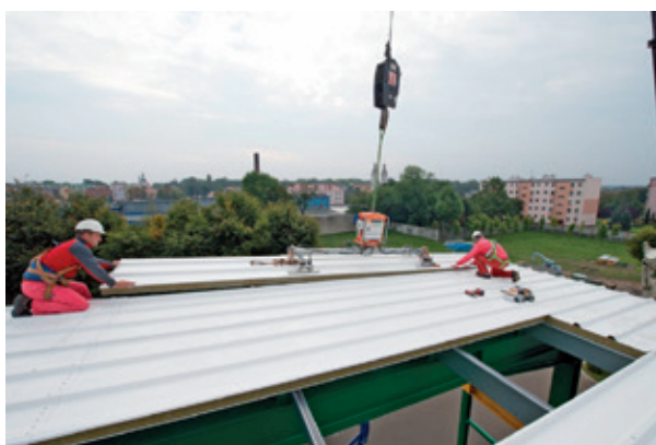
Obr. 10 a 11. Montáž střešních panelů.
